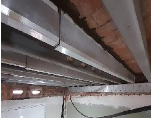
Img.9: Soporte especial continuo viga
