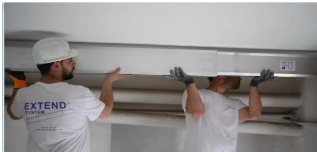
Img: 16: instalación de las vigas por dos operarios
