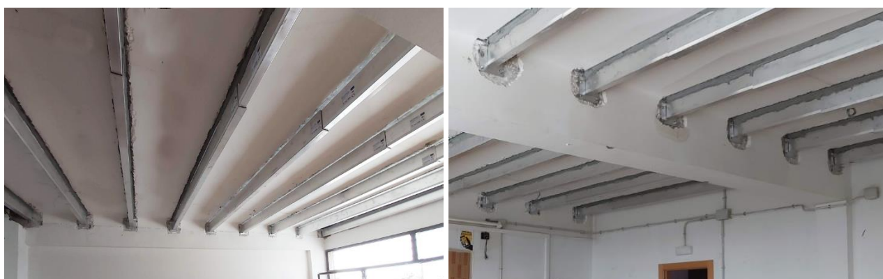
Img.1-2: Refuerzo ejecutado en el IES Mataró. Instalación de 350 vigas en 3 semana
