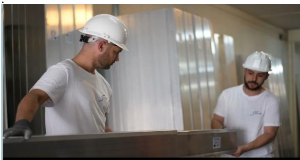
Img.15: Manipulación de las vigas
